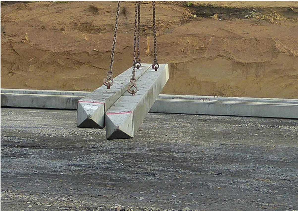
In der letzten Woche haben die Pfahlarbeiten beim Bauvorhaben in der Hildegardstraße in Bochum-Hamme begonnen. Insgesamt wird das Gebäude mit 55 Wohneinheiten auf 124 Stahlbetonfertigteilepfählen mit Pfahllängen von bis zu 15 m und Querschnittsabmessungen von 30 x 30 cm bis 40 x 40 cm gegründet.
