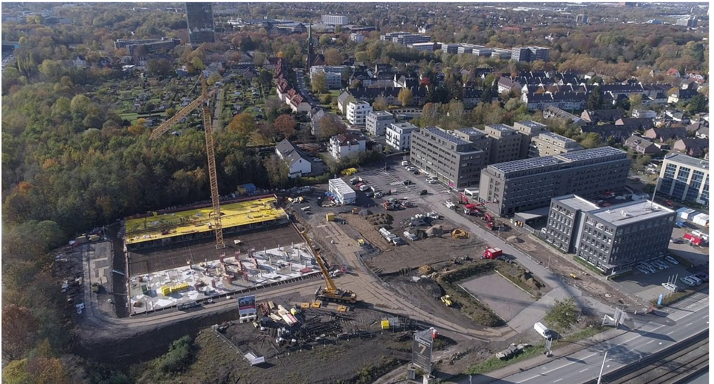
„Baustelle Community-Campus Bochum, Stand: Anfang November 2020“
